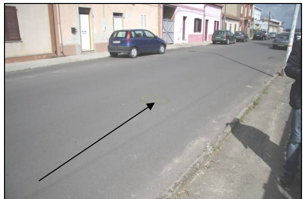
Immagine 4.16 - Pozzetto F nella via Pascoli.
