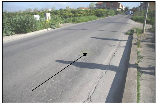
Immagine 4.8 - Pozzetto A nella via Villacidro.
