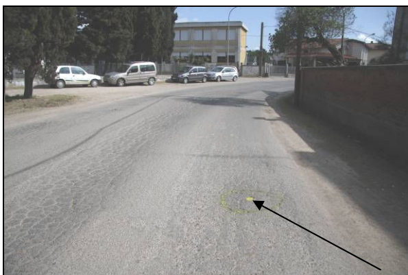
Immagine 4.25 – Pozzetto M nella via Dante.
