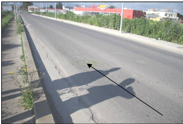
Immagine 4.7 – Pozzetto A nella via Villacidro.
