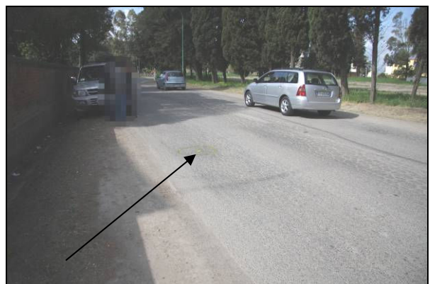
Immagine 4.26 - Pozzetto M nella via Dante.
