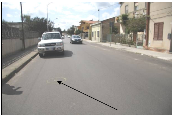
Immagine 4.15 – Pozzetto F nella via Pascoli.
