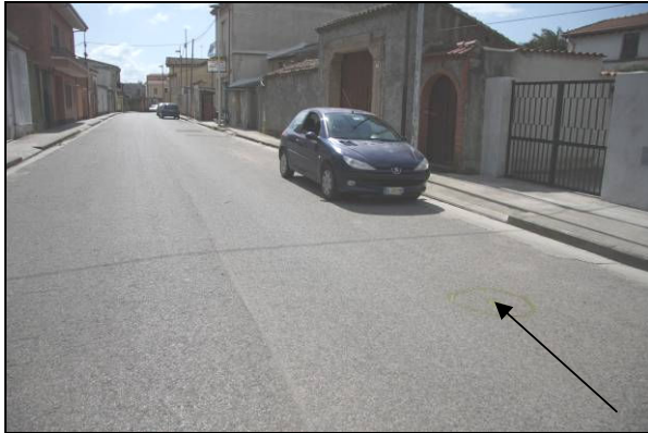
Immagine 4.19 – Pozzetto H nella via Eleonora d'Arborea.
